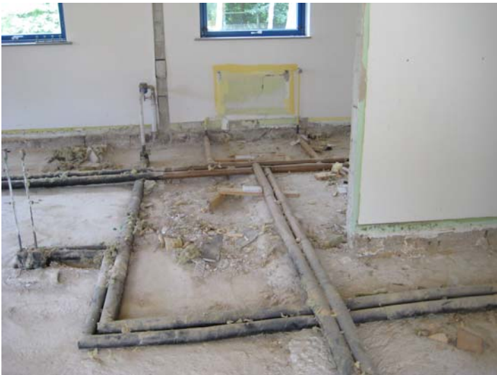
Gulvet er fjernet og der er klar til demontering af rørinstallationer
