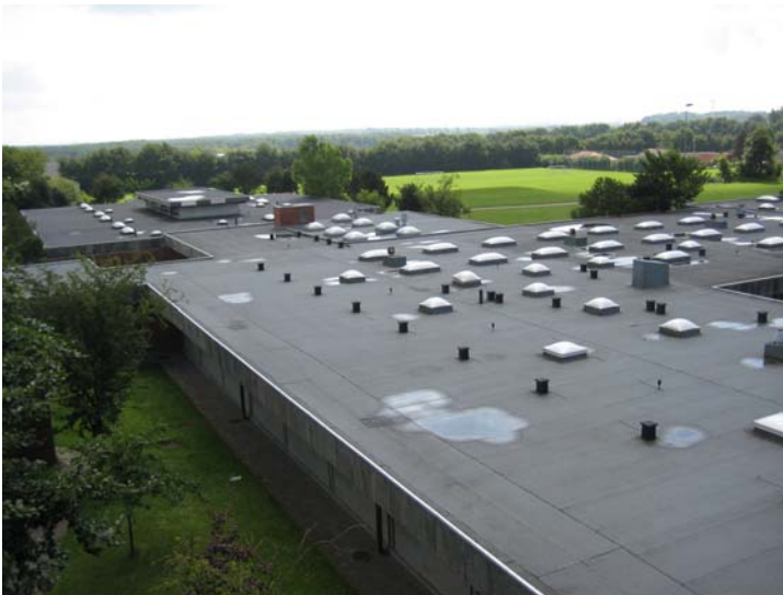
Skolen er med et koldt udeluftventileret tag fra 1970.
